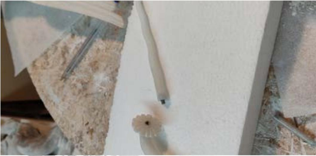
ricostruzione alloggiamento filettato e vite in acciaio in sostituzione del vecchio perno in legno ormai logoro
